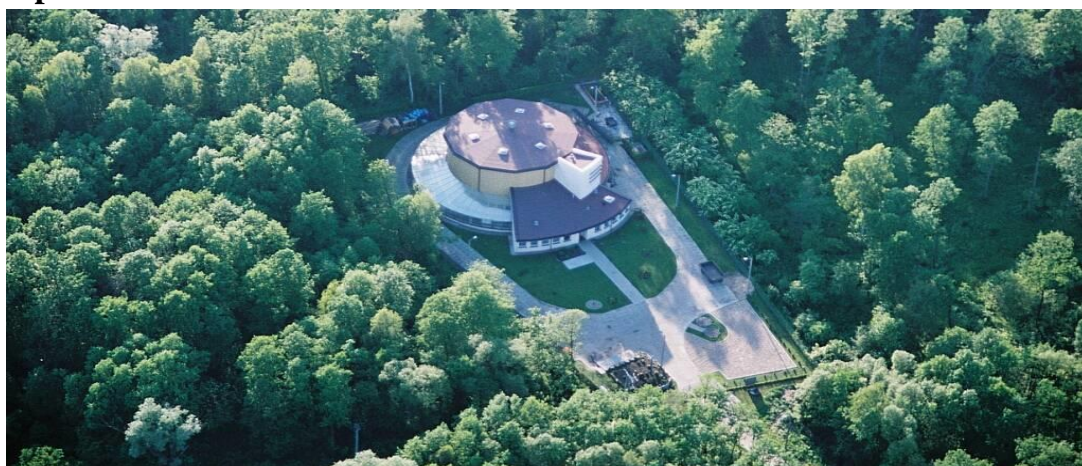
Gminna oczyszczalnia ścieków w Komorach Dąbrownych
