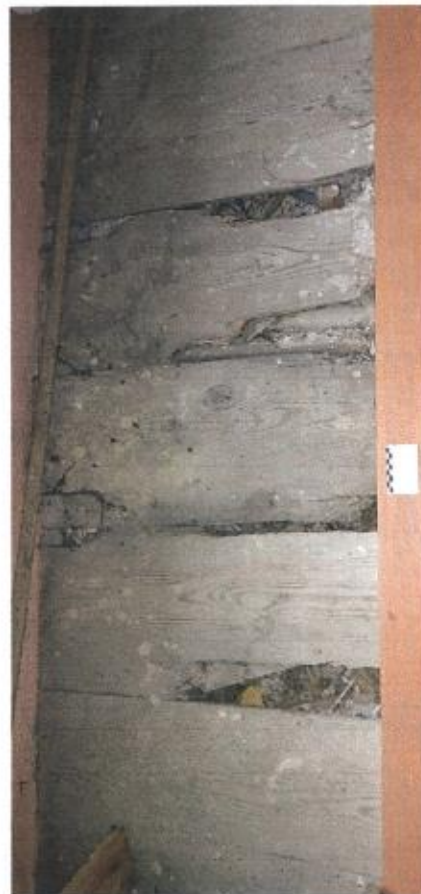
Fot.11,12. Kościół pw. Przemienienia Pańskiego, Sońsk, prospekt organowy, lico szafy, widoczne zniszczenie struktury drewna i ślady żerowania szkodników, elementy z wtórnymi warstwami polichromii, fot. E. Bogdanowicz .Fot.13 A Zarwana podłoga przy oknie. Fot. R. Gazda'2024
