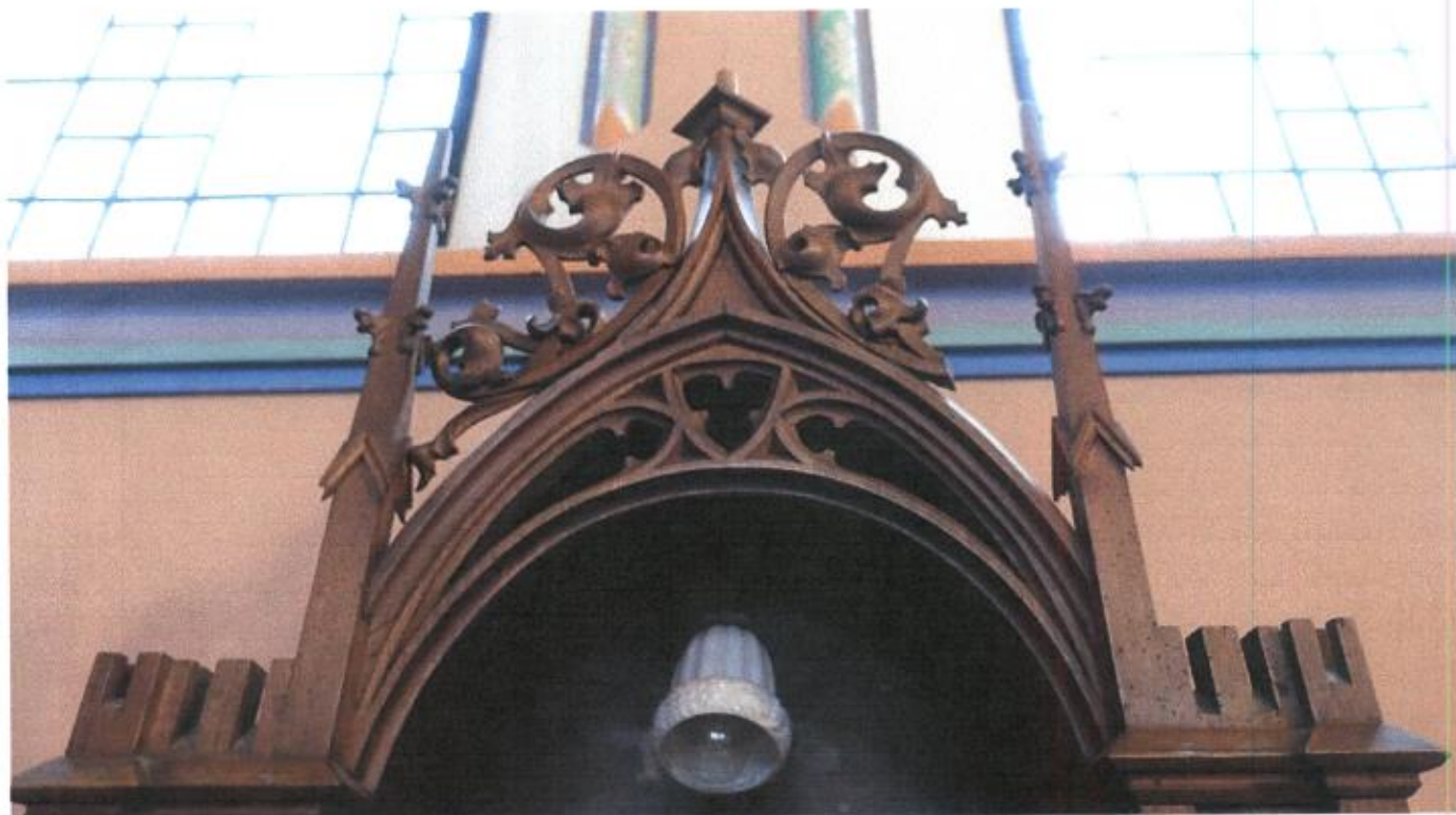
Fot. 4. Kościół pw. Przemienienia Pańskiego, Sońsk, konfesjonał, nawa, ściana lewa, ubytki formy snycerskiej, pełzanek, kwiatonów, ornamentu z liściem akantu, fot. A. Bogusz - Gazda
