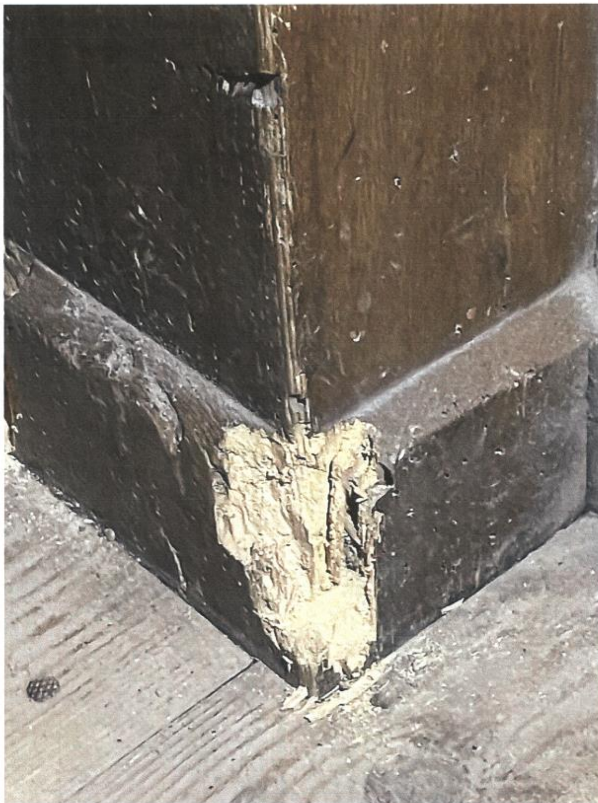
Fot.8. Kościół pw. Przemienienia Pańskiego, Sońsk, prospekt organowy, lico szafy, widoczne zniszczenie struktury drewna i ślady żerowania szkodników, fot. R. Gazda
