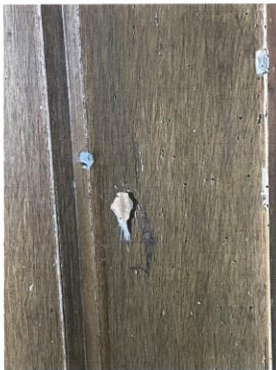
Fot.11,12. Kościół pw. Przemienienia Pańskiego, Sońsk, prospekt organowy, lico szafy, widoczne zniszczenie struktury drewna i ślady żerowania szkodników, elementy z wtórnymi warstwami polichromii, fot. E. Bogdanowicz .Fot.13 A Zarwana podłoga przy oknie. Fot. R. Gazda'2024
