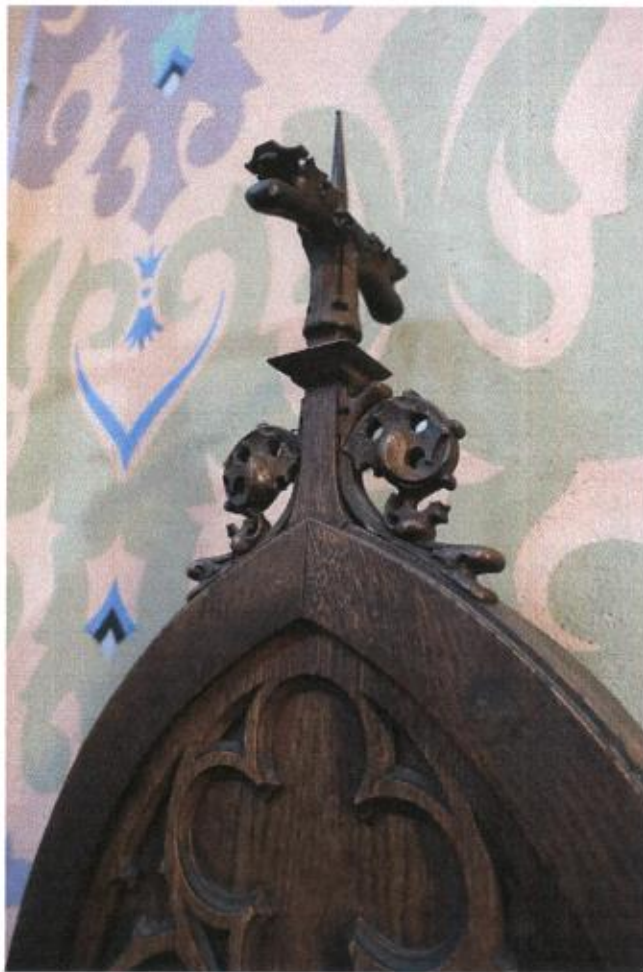
Fot.15. Kościół pw. Przemienienia Pańskiego, Sońsk, Ławka kolatorska, prezbiterium, prawa strona ołtarza po lewej stronie drzwi do Kaplicy, ubytek formy snycerskiej zwieńczenia zaplecka, fot. A. Bogusz - Gazda
