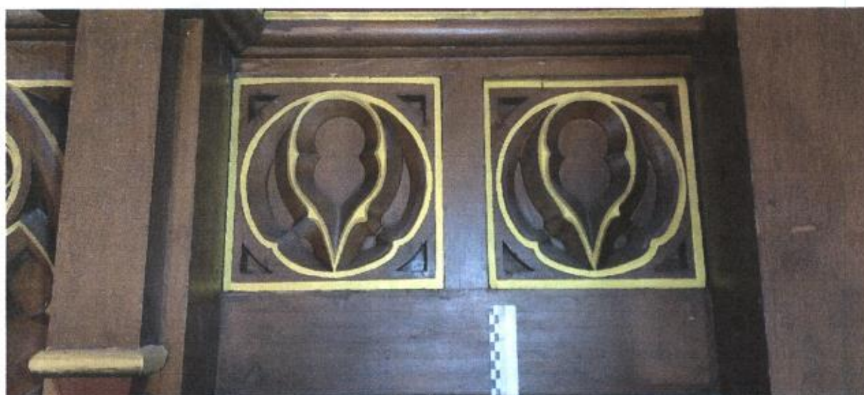
Fot.5,6. Kościół pw. Przemienienia Pańskiego, Sońsk, prospekt organowy, lico szafy, widoczne wtórne polichromowanie i złoceń, fot. R. Gazda
