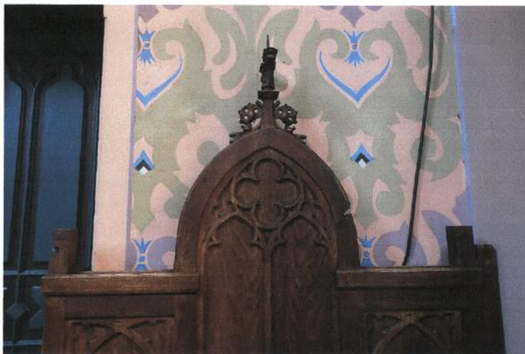
Fot.17,18. Kościół pw. Przemienienia Pańskiego, Sońsk, Ławka kolatorska, prezbiterium, prawa strona ołtarza po prawej stronie drzwi do Kaplicy, ubytek pasa ornamentu kostkowego i uszkodzenie słupka narożnego, ubytki formy kwiatonu w zwieńczeniu zaplecka, fot. A. Bogusz - Gazda
