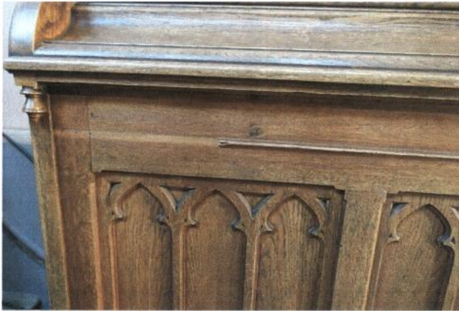
Fot.14. Kościół pw. Przemienienia Pańskiego, Sońsk, Ławka kolatorska, prezbiterium, prawa strona ołtarza po lewej stronie drzwi do Kaplicy, ubytek listwy , fot. A. Bogusz - Gazda
