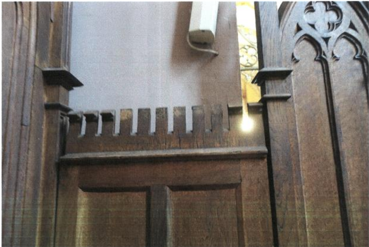
Fot.9. Kościół pw. Przemienienia Pańskiego, Sońsk, konfesjonal jednostronny, prezbiterium, po prawej stronie ołtarza, widoczne ubytki formy snycerki w ornamencie kostkowym, fot. A. Bogusz - Gazda
