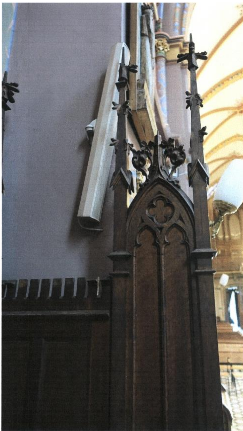
Fot.8. Kościół pw. Przemienienia Pańskiego, Sońsk, konfesjonal jednostronny, prezbiterium, po prawej stronie ołtarza, widoczne ubytki formy snycerki w zwieńczeniu i pinaklach, fot. A. Bogusz - Gazda
