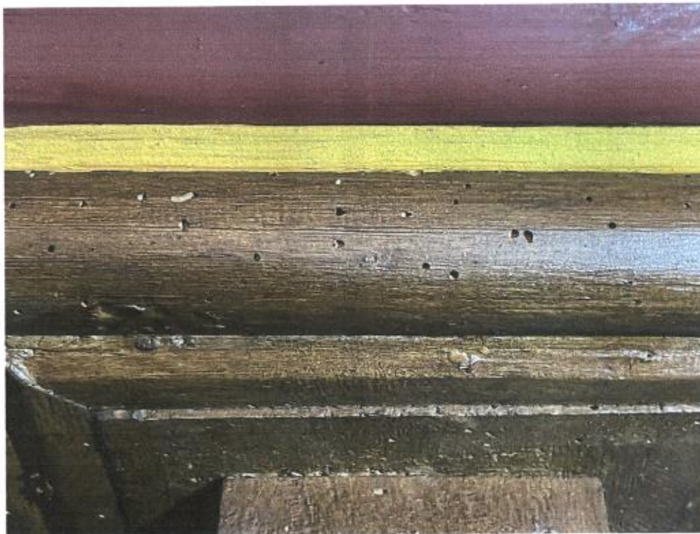
Fot.14,15. Kościół pw. Przemienienia Pańskiego, Sońsk, prospekt organowy, lico szafy, widoczne elementy z wtórnymi warstwami polichromii i złocenia, ślady żerowania szkodników fot. E. Bogdanowicz
