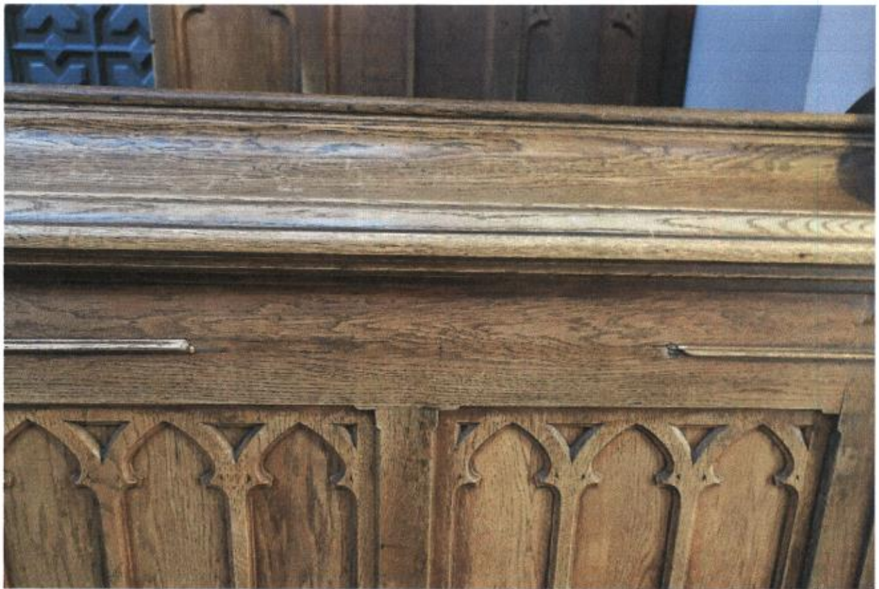
Fot.19. Kościół pw. Przemienienia Pańskiego, Sońsk, Ławka kolatorska, prezbiterium, prawa strona ołtarza po prawej stronie drzwi do Kaplicy, ubytek listwy profilowanej na ścianie licowej, fot. A. Bogusz - Gazda
