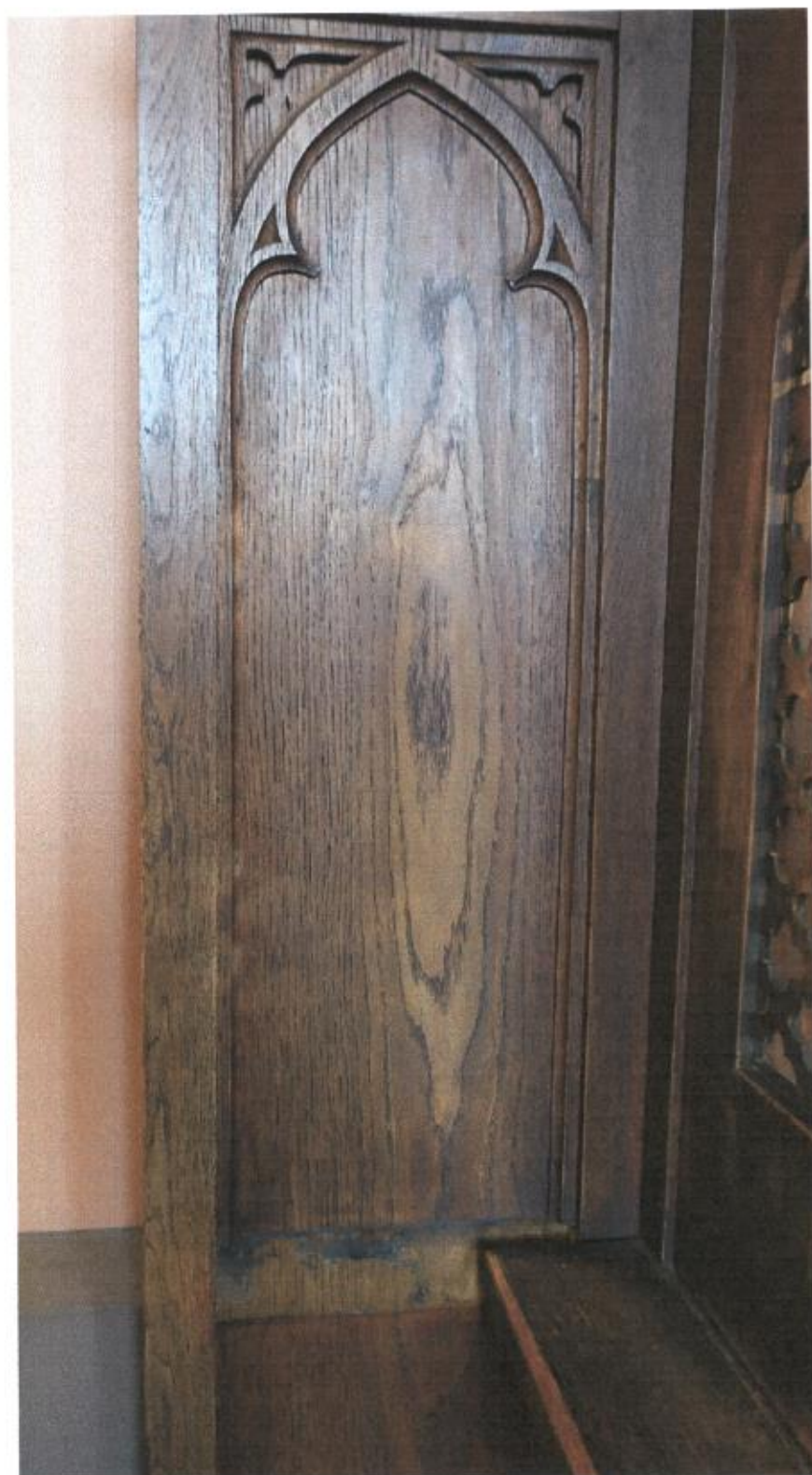
Fot. 6. Kościół pw. Przemienienia Pańskiego, Sońsk, konfesjonał, nawa, ściana lewa, ubytek listwy, fot. A. Bogusz - Gazda
