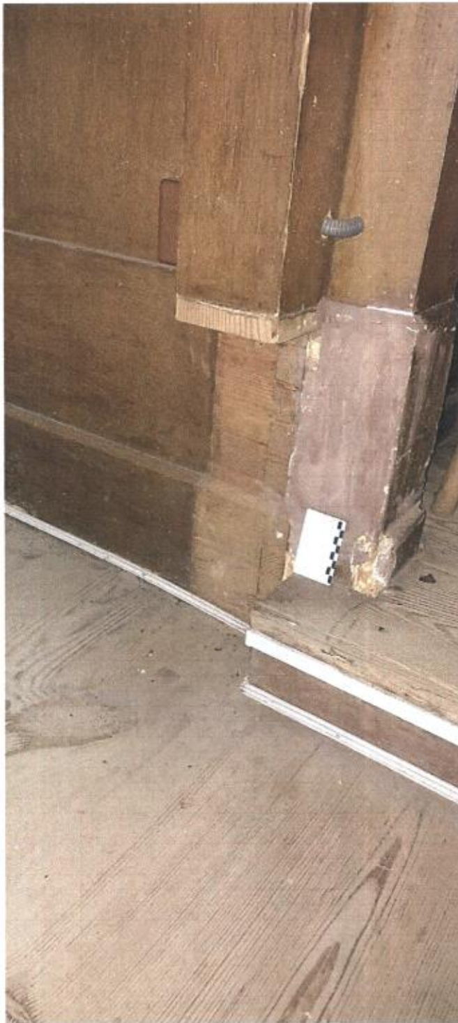
Fot.4. Kościół pw. Przemienienia Pańskiego, Sońsk, prospekt organowy, bok szafy, ubytek formy słupka, fot. R. Gazda
